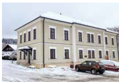
Pracoviště VUZ v Mostech u Jablunkova
