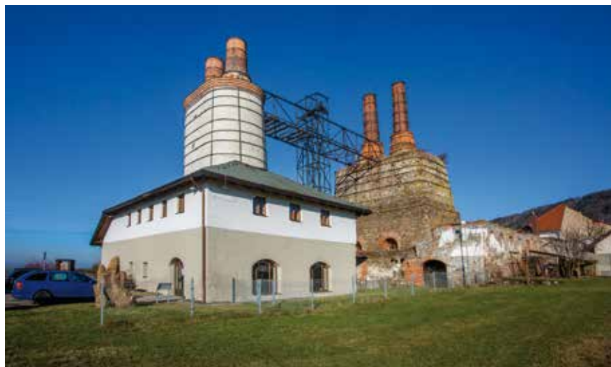
Berlova vápenka prošla před deseti lety zdařilou rekonstrukcí
