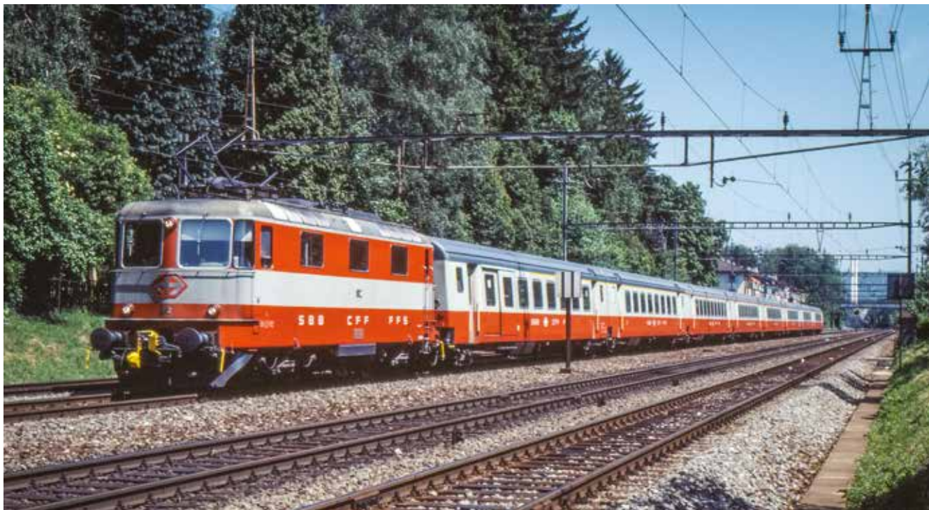
Swiss Express v charakteristických barvách v čele s řadou Re 4/4 II. Zřetelné je automatické spráhlo pro tyto soupravy i odlišný znak na čele.
