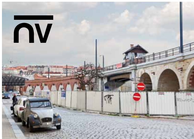
Takto vypadal Negrelliho viadukt v březnu 2020.
