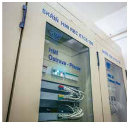
Skříň řídicí úrovně (HMI) Radioblokové centrály systému ERTMS/ETCS
