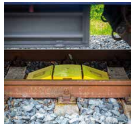
Eurobalíza je základním prvkem traťové části systému ERTMS/ETCS.
