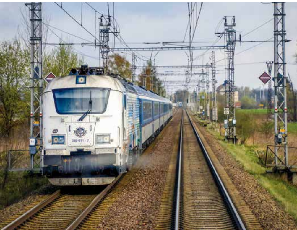
Ilustrační foto s ukázkou stykového místa, kde přechází střídavá trakce na stejnosměrnou.
