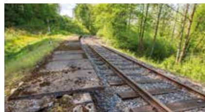
Nástupiště zastávky Zlaté Hory-Na mlýnech
