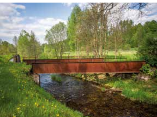
Dochovaný ocelový most přes Olešnici
