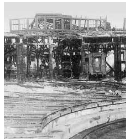
Poškozená topárna byla kompletně opravena a její osud byl definitivně zpečetěn až v roce 2014.
