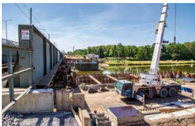
Nový dvoukolejný most přes Labe vyroste v těsné blízkosti stávajícího.
