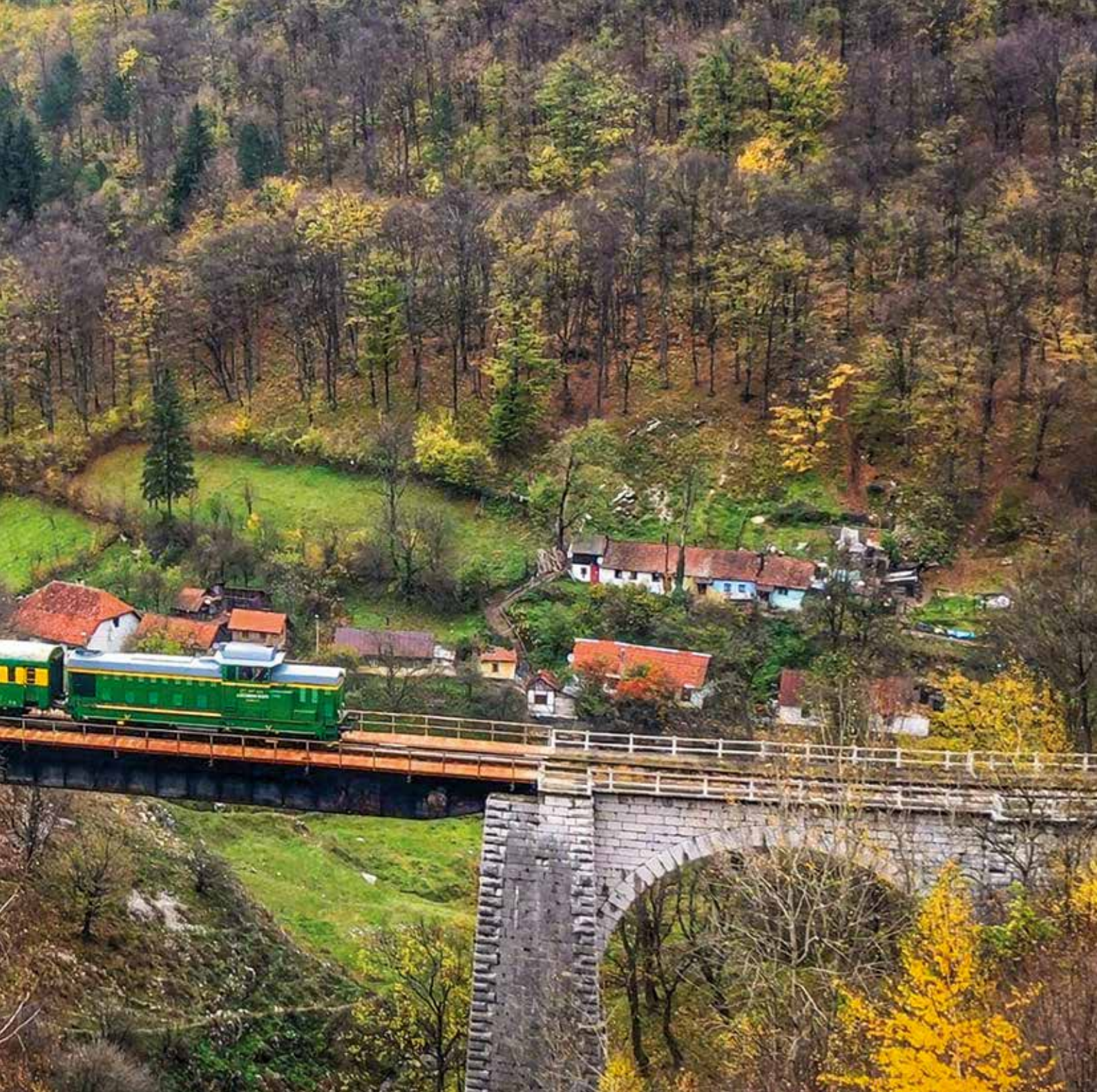
Pohled na trať z Oravity do Aniny s nepřehlédnutelným viaduktem. Dráha vyniká mimořádnou stavební náročností. Vzniklo zde i 10 viaduktů o délce 843 metrů.
