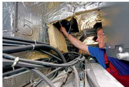
Instalace externí antény pro příjem GSM a LTE signálu ve vozech Bdmpee
