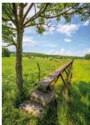
Vstup na ocelovou lávku u Zbraně
