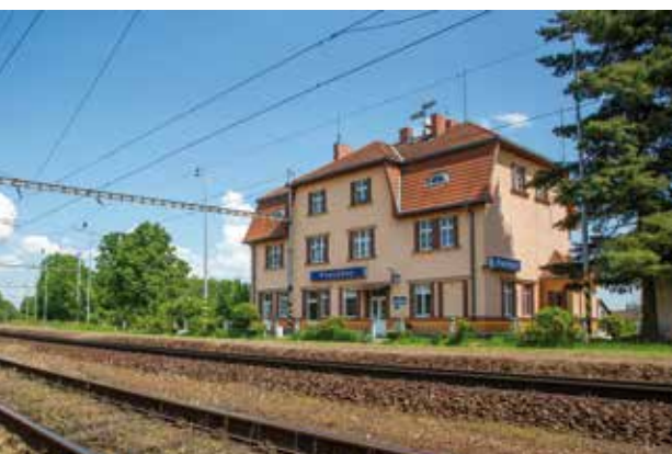
Budova převýšovského nádraží je vzorně udržována
