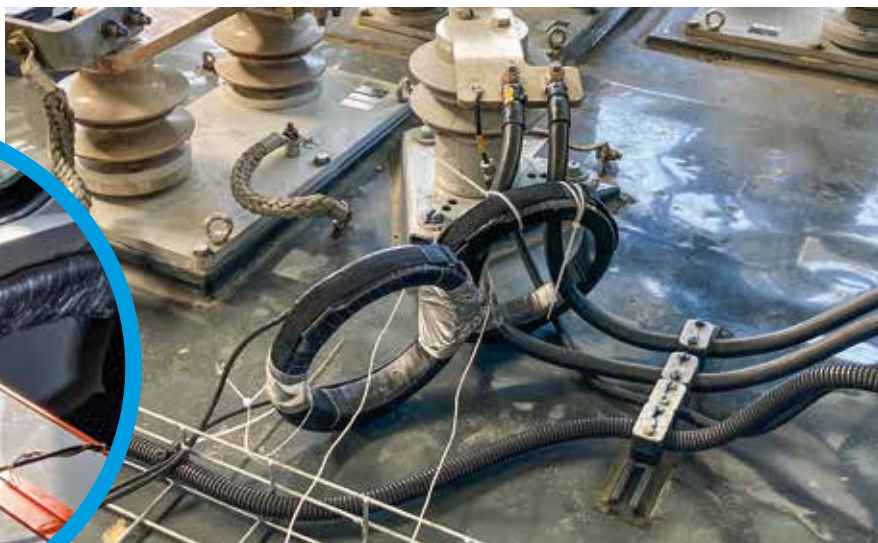
Měřicí cívka na střeše vozidla
