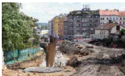
Budoucí stanice Praha-Výstaviště
