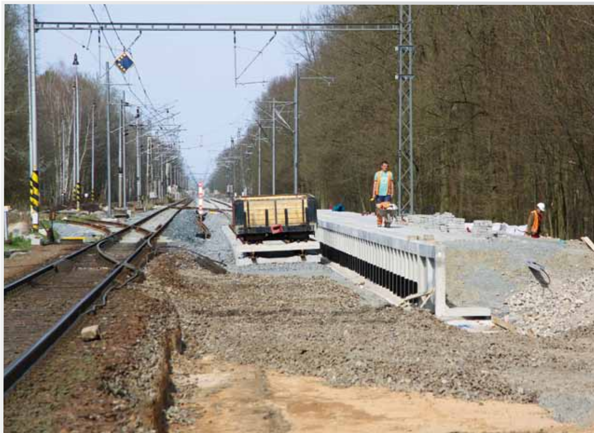
REKONSTRUKCE. Práce na úseku Stěblová – Opatovice znamenaly i kompletní vyloučení železniční dopravy. FOTO AUTOR
