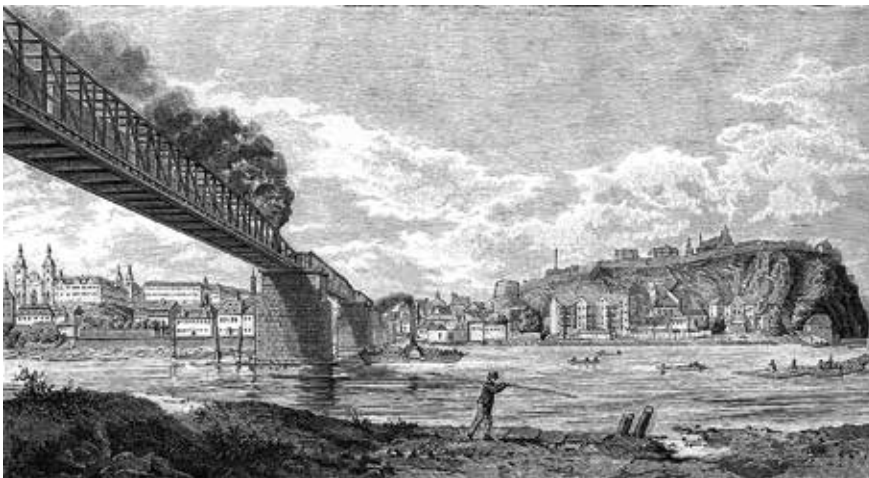
První železniční most přes řeku Vltavu pod Vyšehradem měl pět železných polí a čtyři pilíře, z nichž tři stály v řece. Na obrázku z 19. století (asi rok 1872) vidíme od něj vpravo na skále Vyšehrad a vlevo klášter Emauzy.
