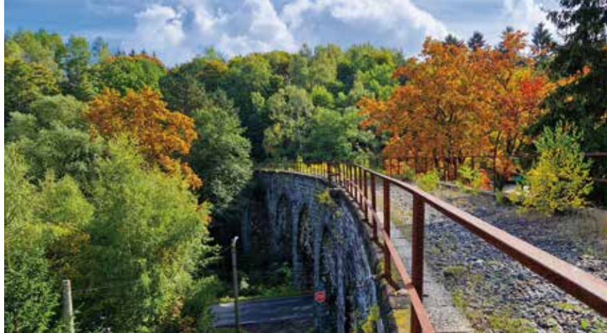
Osiřelý viadukt v Horním Slavkově – trať je ve „výluce“ od roku 1997.
