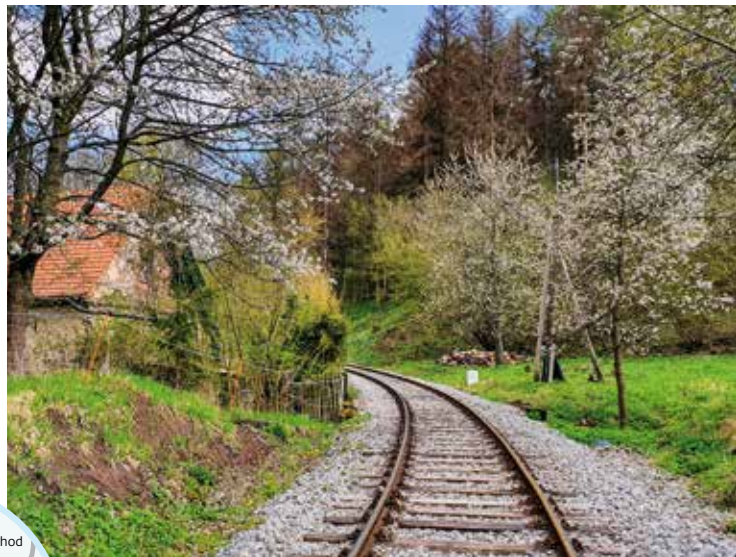
Obnovená trať nad Zubrnici ve směru na Úštěk
