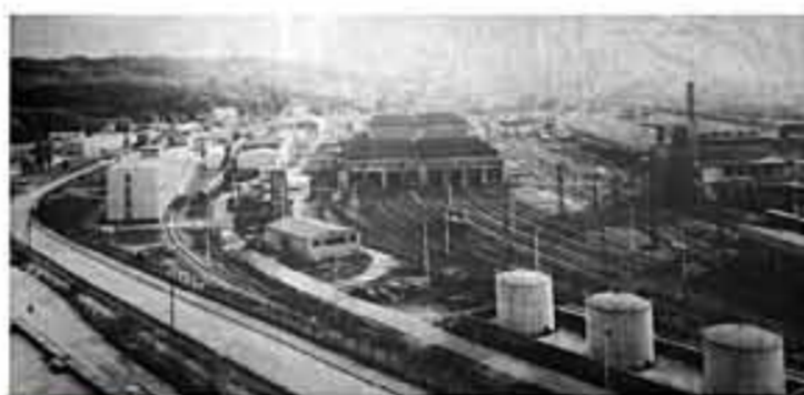
Typický pohled. Aerialní pohled na Maloměřické depo a část přilehlých kolejí.
