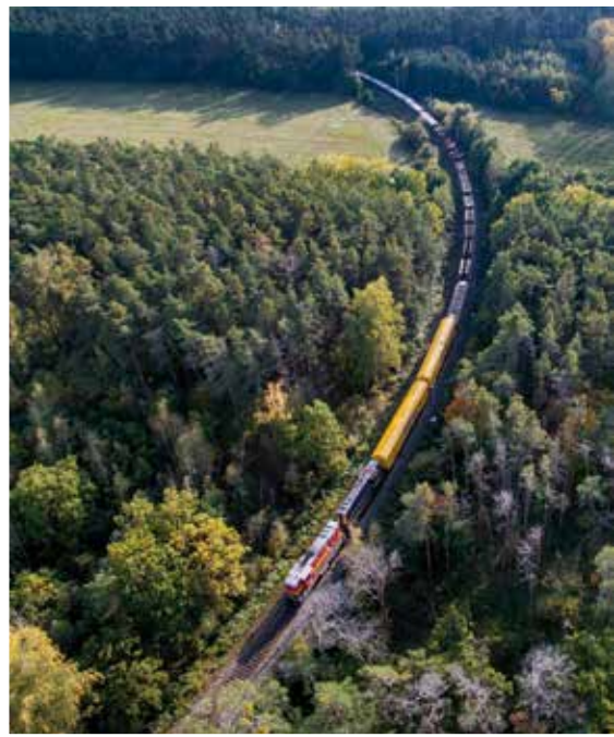
← Začátek soupravy unikátního stavebního stroje RUS 1000 S →
