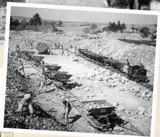
↑ První a poslední železnice v českých Lidicích. Byla vybudována Němci pro urychlení zahazení místa, kde stávala obec. Příslušníci Říšské pracovní služby po úzkorozchodné železnici odváželi na různá místa kolem bývalé obce její zbytky (zaváželi rokle, úvozy i rybník, naváželi návrší), aby se co nejvíce změnil reliéf krajiny a nebylo poznat, že v těchto místech nějaké lidské sídlo existovalo.
