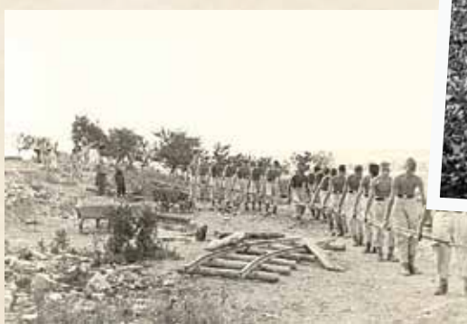
Příslušníci Říšské pracovní služby stavějí úzkorozchodnou železnici v Lidicích u Kladna pro odklizení troskek obce, kterou 10. 6. 1942 jejích soukmenovci vyhladili. Sami ani netuší, že někteří z nich budou podobné železnice stavět za několik let i na německé půdě. →
