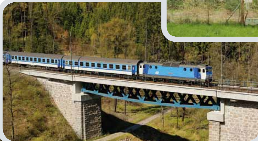
Zdejší železniční mosty si díky absenci protihlukových stěn zachovaly své původní kouzlo i po rekonstrukci.
