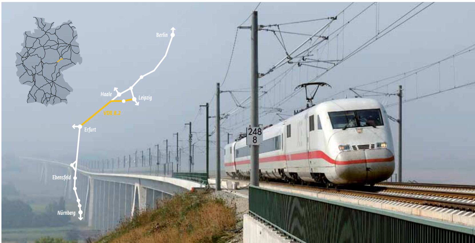
VIADUKTY. Na trati se nachází šestice velkých mostů o celkové délce přes třináct kilometrů.
