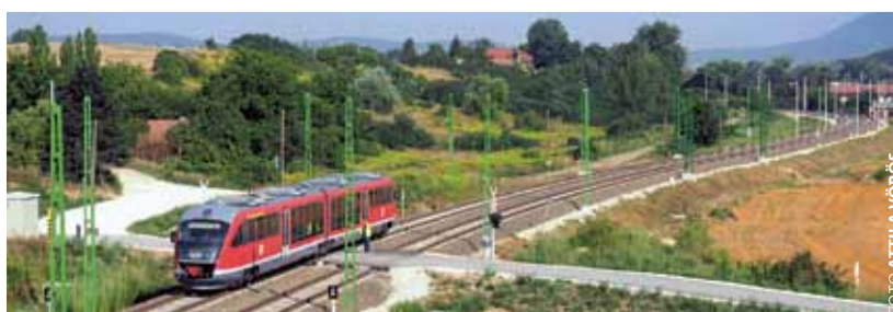
BEZ DRÁTŮ. Stále tu jezdí motoráky, trakční vedení ještě nebylo nainstalováno.
