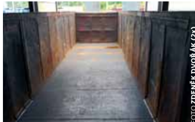
Vůz po odstranění dřevěné podlahy (nahore) a po rekonstrukci (dole).
