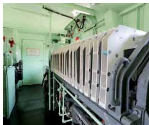
Pohled do kompletně zrekonstruované strojovny lokomotivy E 422.0003
