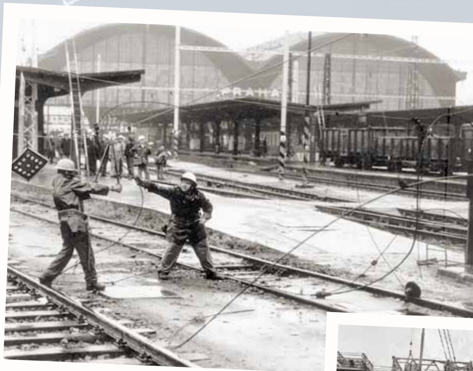
Montáž nového trakčního vedení v žst. Praha hl. n. v roce 1976
