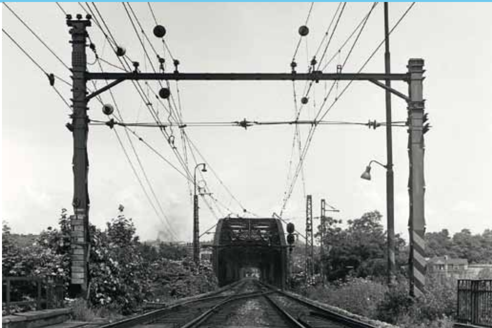
Původní trakční vedení na vyšehradském železničním mostě
