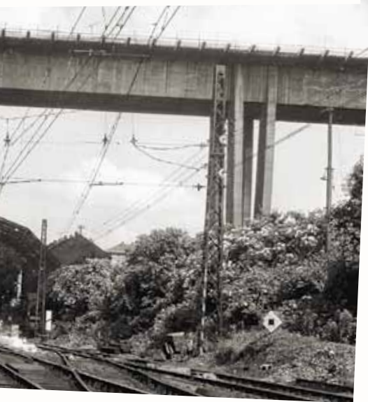
Původní trakční vedení u měnirny Křenovka, na snímku jsou patrné podpěry nového trakčního vedení.
