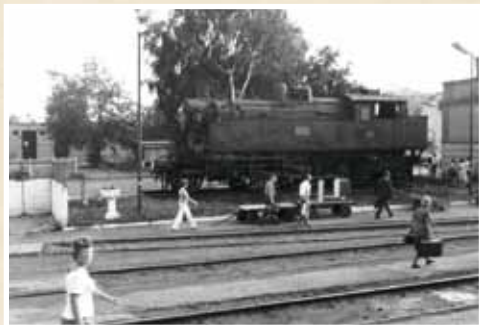
Snímek pomníku v železniční stanici Vác je z roku 1979 a připomíná parní provoz na maďarských železnicích. Sem vedla z Budapešti první železniční trať pro parní provoz.
