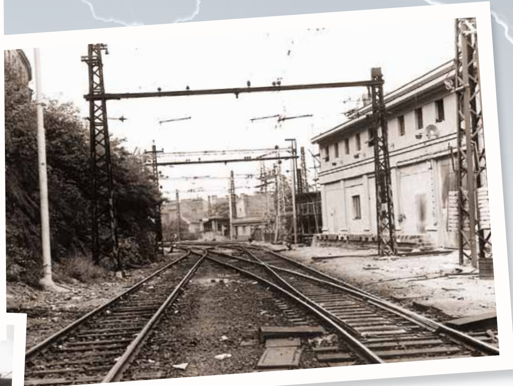
Původní trakční vedení u měnirny Křenovka, na snímku jsou patrné podpěry nového trakčního vedení.
