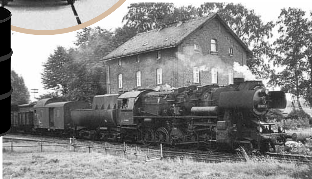
Železniční stanice Baruth určená pouze pro nákladní dopravu s lokomotivou 52 8189-4 v červenci roku 1986
