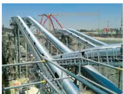
Pásový dopravník přepravující vytěžnou zeminu imponuje svými rozměry.
