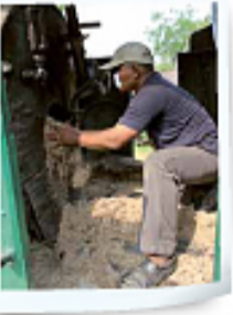
Občasná lokomotiva je mnohdy velmi náročná. Do betonu se připevňuje ručně.
