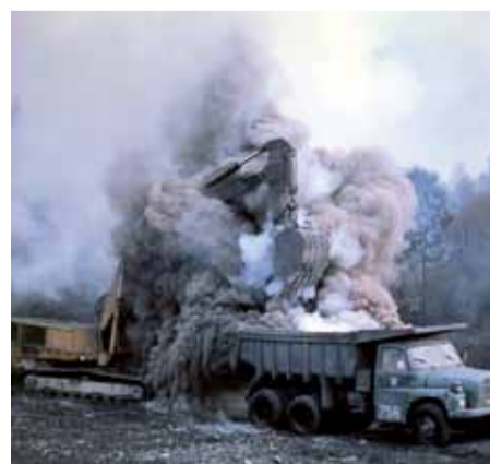
LIKVIDACE. Hořící drážní těleso odtěžily bagry, aby se oheň dál nešířil. FOTO AUTOR 3X
