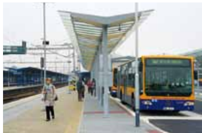
Přestup mezi vlakem a autobusem je na stejné výškové úrovni. FOTO AUTOR
