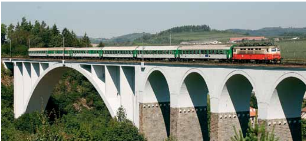
Plecháč v „polomáceném“ nátěru na viaduktu v Dolních Loučkách
